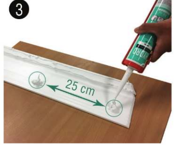
Apply DecoFix Hydro in V-Fix over the entire length Breng DecoFix Hydro over de volledige lengte aan in V-Fix | Appliquez DecoFix Hydro sur toute la longueur dans V-Fix | Tragen sie den DecoFix Hydro in die V-Fugen entlang des Profiles auf | Aplicar DecoFix Hydro en V-fix a lo largo de todo el perfil
