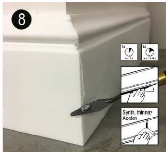
Remove excess adhesive in joints with spatula after max. 1 hr, repeat after 2-3 hours. Clean with Acetone/synth. Thinner | Verwijder de overtollige lijm vóór uitharding (na max. 1 uur en na 2 tot 3 uur) | Éliminez les excès de colle avant le durcissement (1 heure max. et recommencez après 2-3 heures) | Überschüssigen Kleber vor dem Aushärten mit einer Spachtel entfernen durch Abziehen (nach 1 Std und nach 2-3 Std wiederholen) | Eliminar cola excesiva antes de endurecer (max. 1 hora y repetir 2-3 horas después)
